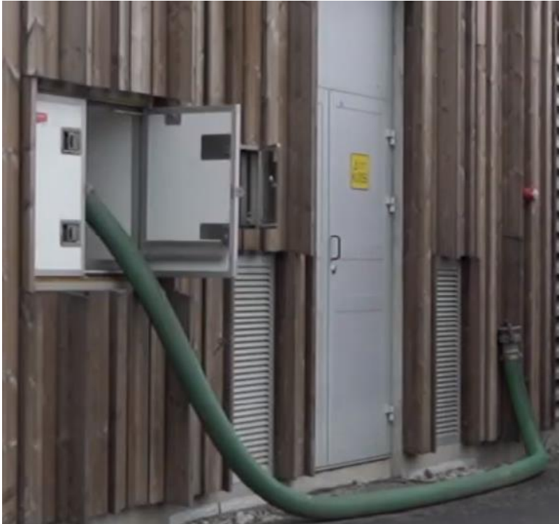
Figur 10: Utvendig slamkiosk for enklere tilkobling til slambil (Tangen RA, Mira IKS)
